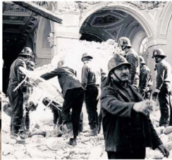
DISTRUZIONE Foto scattate subito dopo il terremoto del 23 novembre 1980 a Balvano, paese simbolo del sisma di 35 anni fa [foto Tony Vecel]
