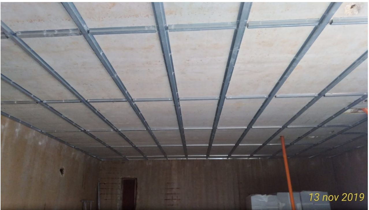
Struttura isolamento intradosso solaio spazi abitati
